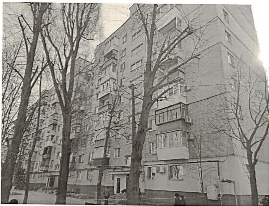
а) Фасад будівлі за сторони двора
